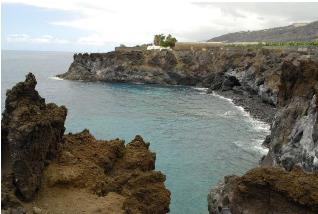
Imagen 7. Extremo sur de la zona de actuación con los escarpes que limitan la playa de Las Monjas.
