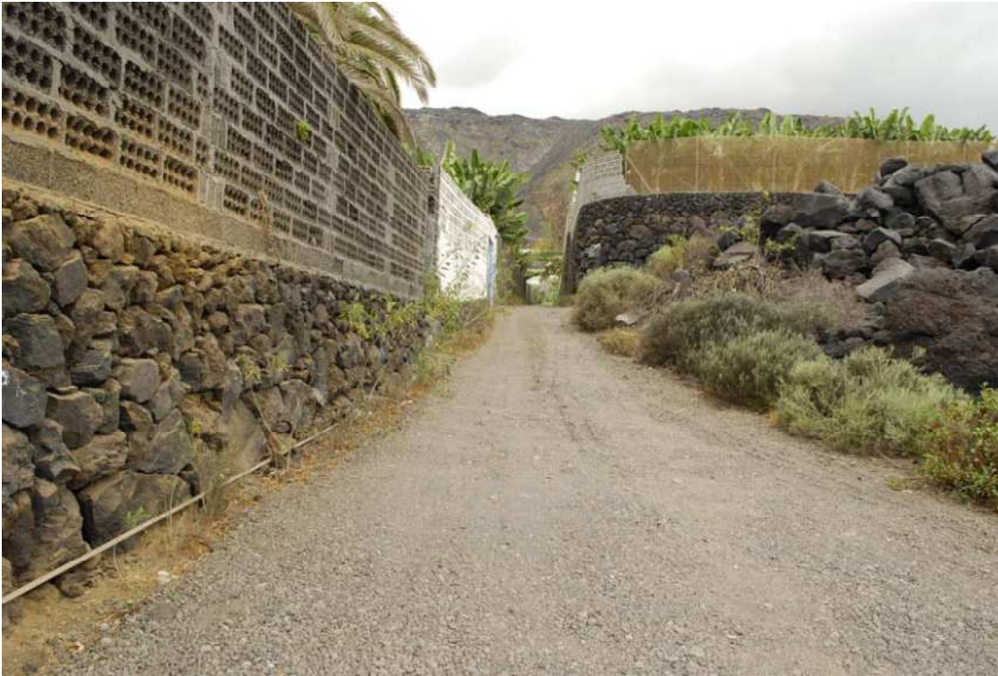
Imagen 21. Muros de mampostería en seco de las fincas de cultivo de platanera
