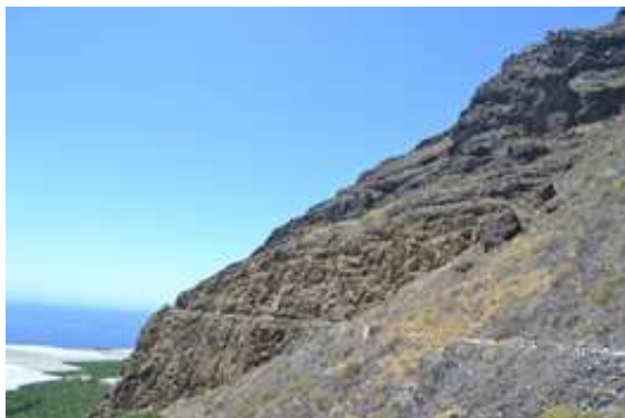
Imagen 33. Canal Las Hoyas – El Remo en el acantilado al este de la actuación
