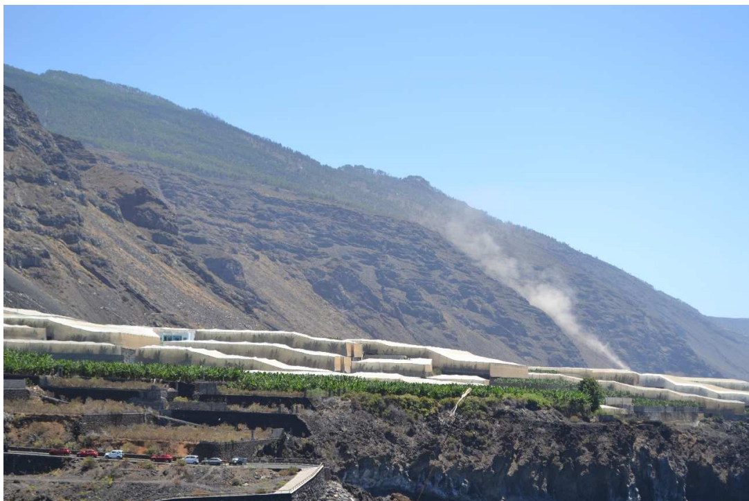
Imagen 31. Movimiento de derrubios al sur de Charco Verde usual en la zona de acantilados.
