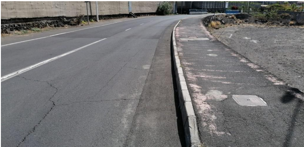
Visual sur: acera 2,05 m. Vía LP-213, a su derecha (poniente) el Sector G3S2.
