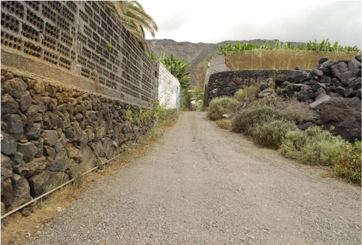
Imagen 22. Muros de mampostería en seco de las fincas de cultivo de platanera
