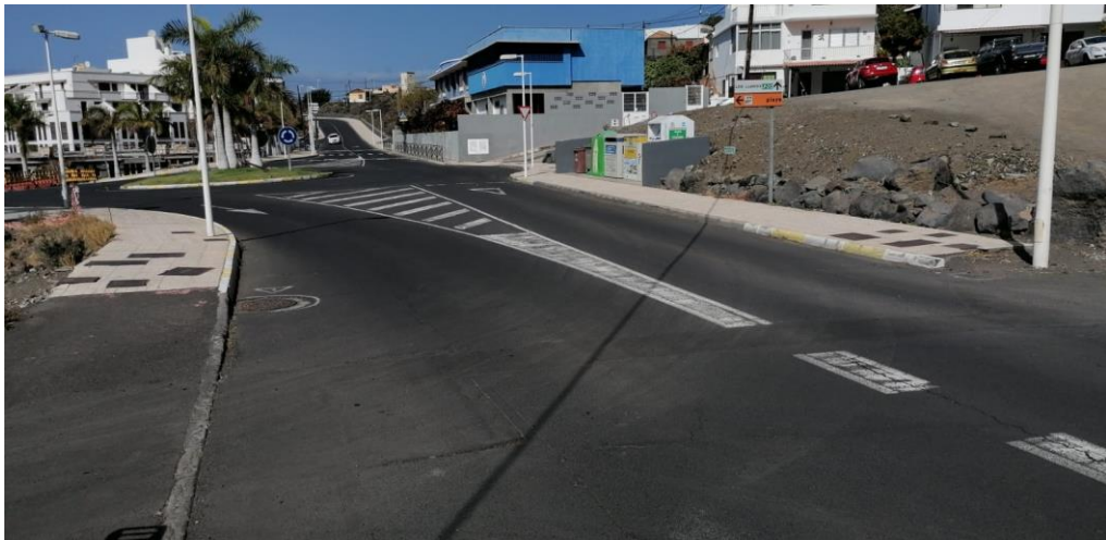
Visual norte: acera 2 m. Vía LP-213 a su paso por casco de Puerto de Naos.
