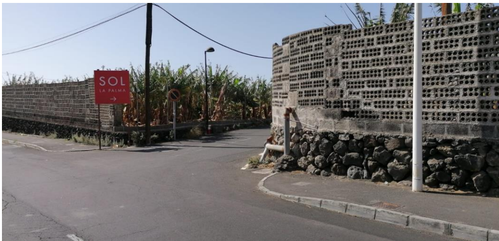
Visual sur: acera 2,2 m. Vía LP-213 y acceso a Hotel Sol, a su derecha (poniente) el Sector G3S3.
